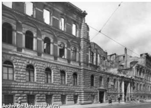
Abb. 3: Straßenansicht nach Zerstörung
