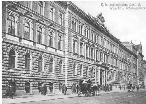
Abb. 2: Straßenansicht vor Zerstörung
